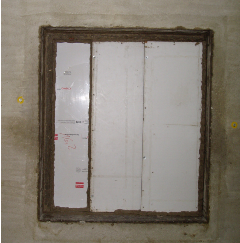
Bild 1 Foto des eingebauten Elementes, erstellt vom ift Schallschutzzentrum
